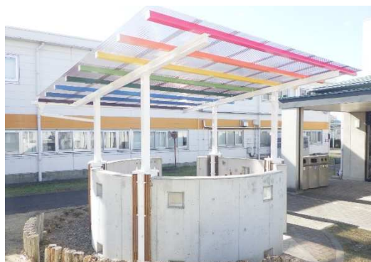
図6 休憩スペースにある構造物の屋根改修(2023年度)
