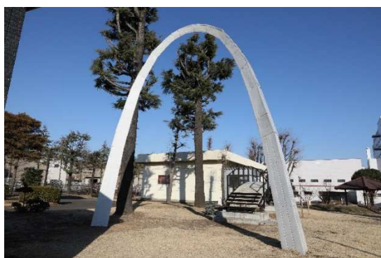
図5 カテナリー曲線によるアーチ構造物の設計・施工(2018年度)
