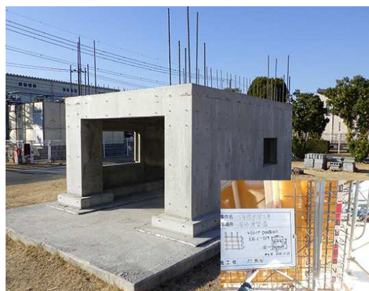
図3 鉄筋コンクリート造施工・ 施工管理課題実習成果物例
